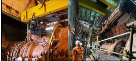
ภาพที่ 2 ตัวอย่างการซ่อมบำรุงเครื่องกังหันก๊าซ
