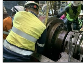
ภาพที่ 3 ตัวอย่างการซ่อมบำรุงเครื่องกังหันไอน้ำ
