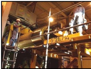
ภาพที่ 4 ตัวอย่างการซ่อมบำรุงเครื่องกำเนิดไฟฟ้า
